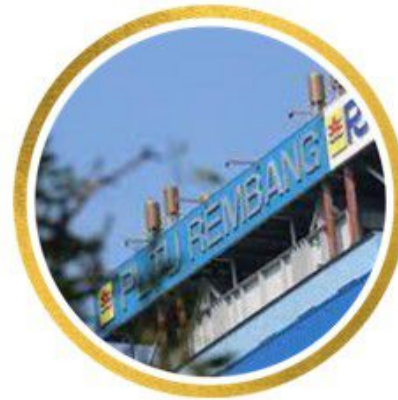
PT. PLN NP UBJOM PLTU REMBANG
