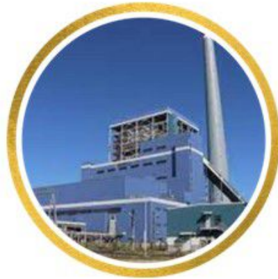
PT. Indonesia Power PLTU JATENG 2 ADIPALA CILACAP
